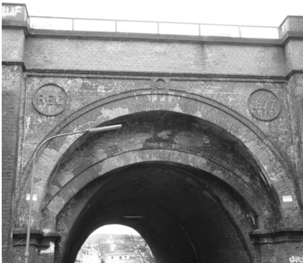
Brücke der REG über die Schönebecker Straße nahe dem Güterbahnhof Loh.
