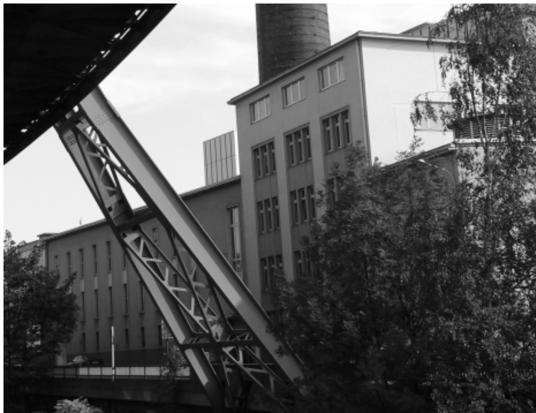
Das Heizkraftwerk Barmen wurde früher „Eltwerk“ genannt.
